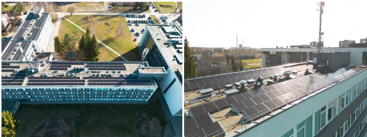
Saulės elektrinė Pramonės pr. 22
