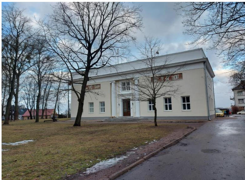
M. K. Čiurlionio galerijos fasadas (po remonto darbų)
