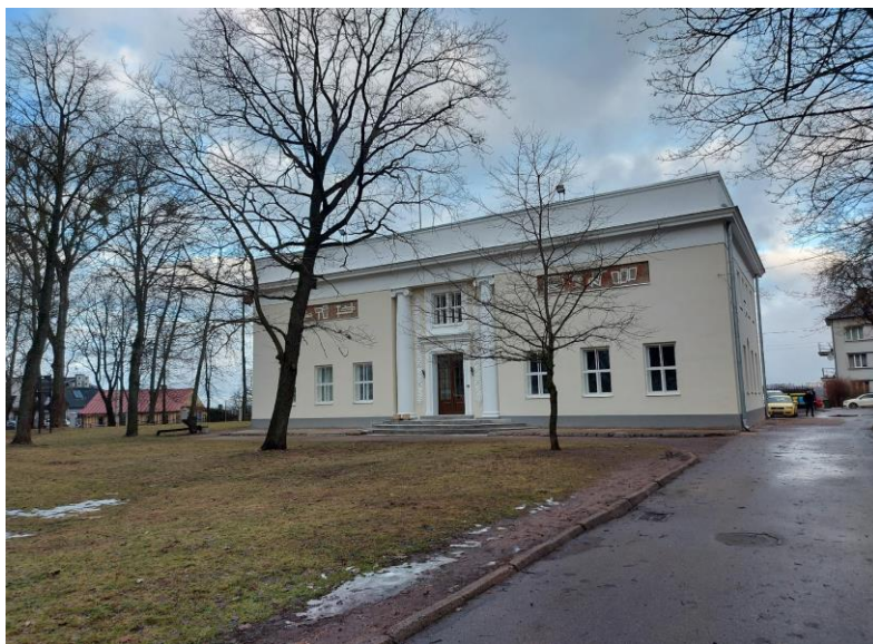
22 pav. M. K. Čiurlionio galerijos fasadas (po remonto darbų)
